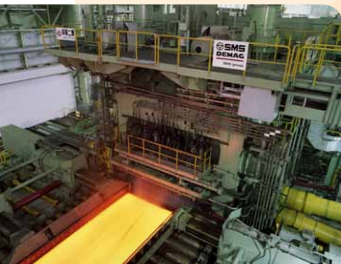
Walzölkühlung durch gedichtete Plattenwärmetauscher.
